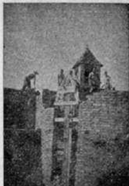
O Templo Nacional, em Lages, S. Catarina, em construção
